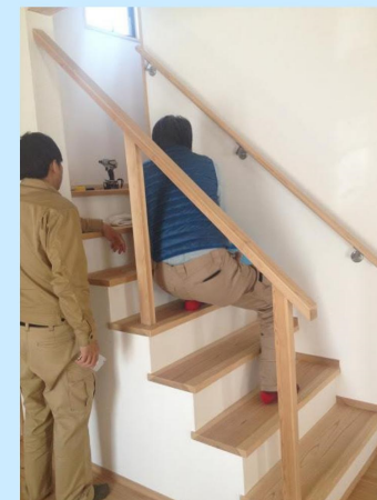
↑ 漆喰の隙間を埋めて貰っています
